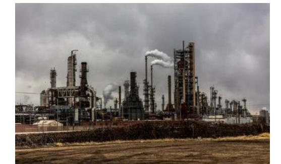
Site en zone SEVESO ou pollué
